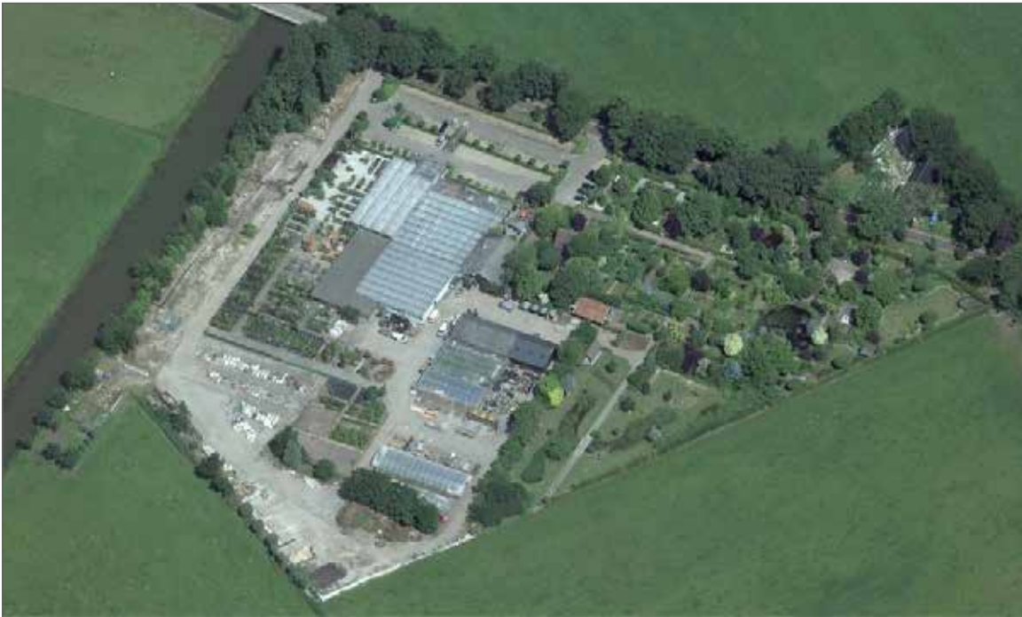
Afbeelding 4.2: Luchtfoto situatie bebouwing juli 2013 (Bron: Streetsmart)
