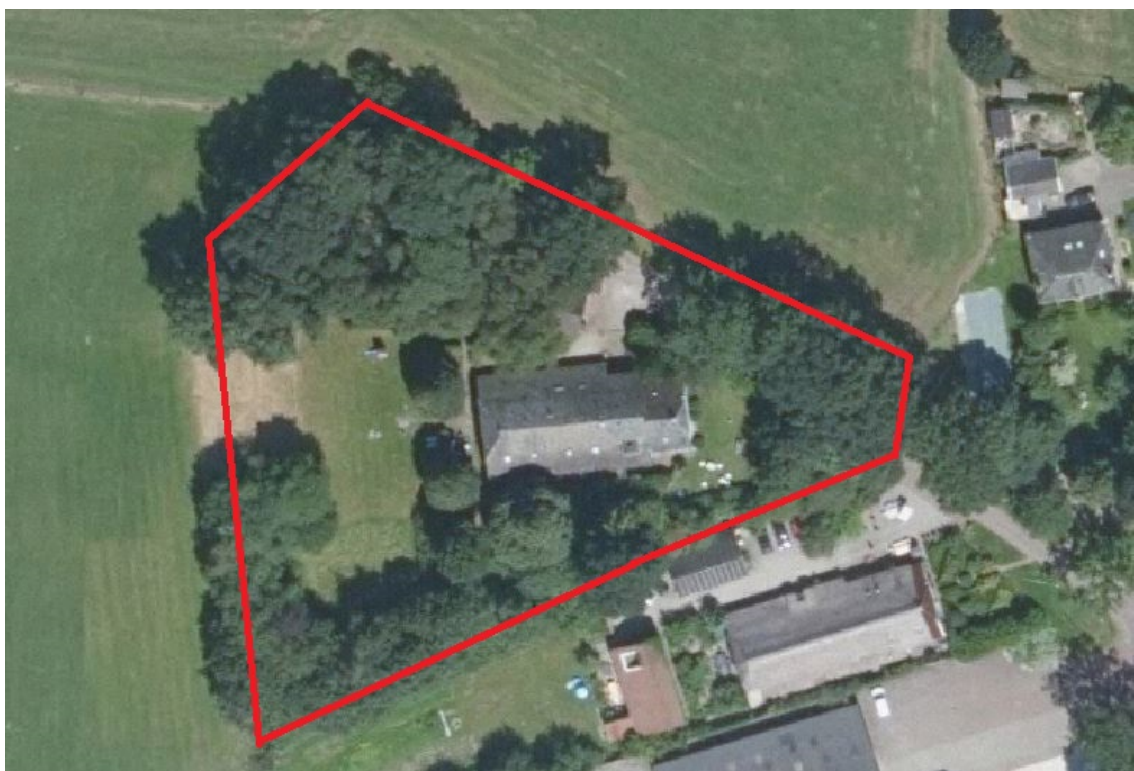
figuur 2.1 Overzicht van het perceel Wittelterweg 12
