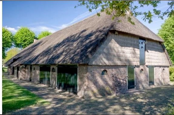
Afbeelding 2.3 aanzicht achter- en rechterzijgevel boerderij (bron: Funda)
