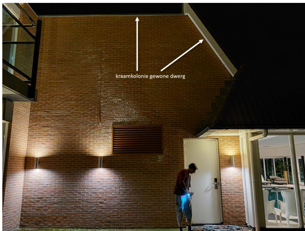
Figuur 19. Verblijf nummer 1: Locatie van de kraamkolonie tussen de metalen daklijst en houten windveer.
