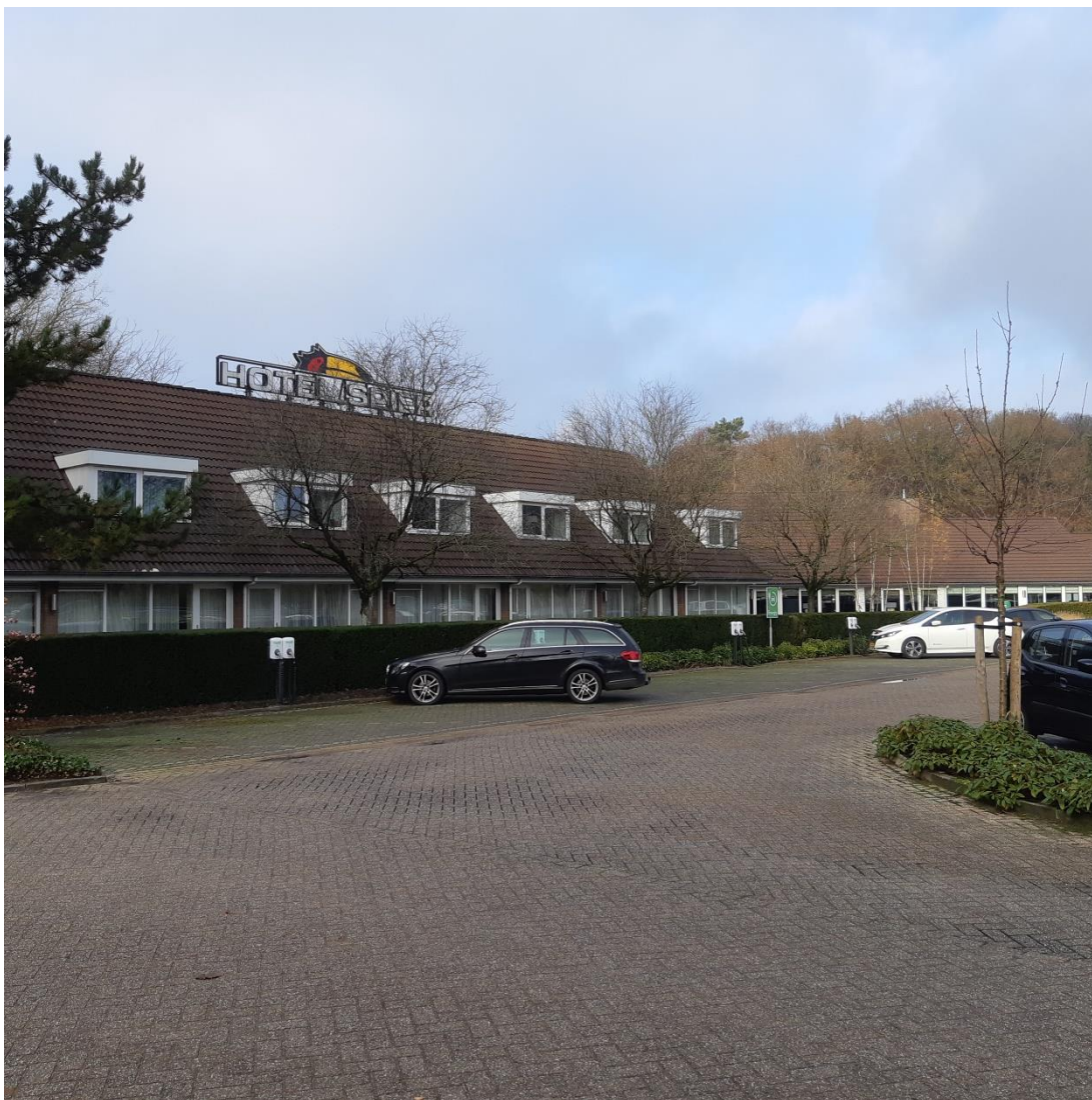
Afbeelding 17: Impressie van het plangebied ten tijde van het booronderzoek. Foto vanaf de zuidoostzijde (parkeerplaats bij de entree van het hotel) richting het noorden.
