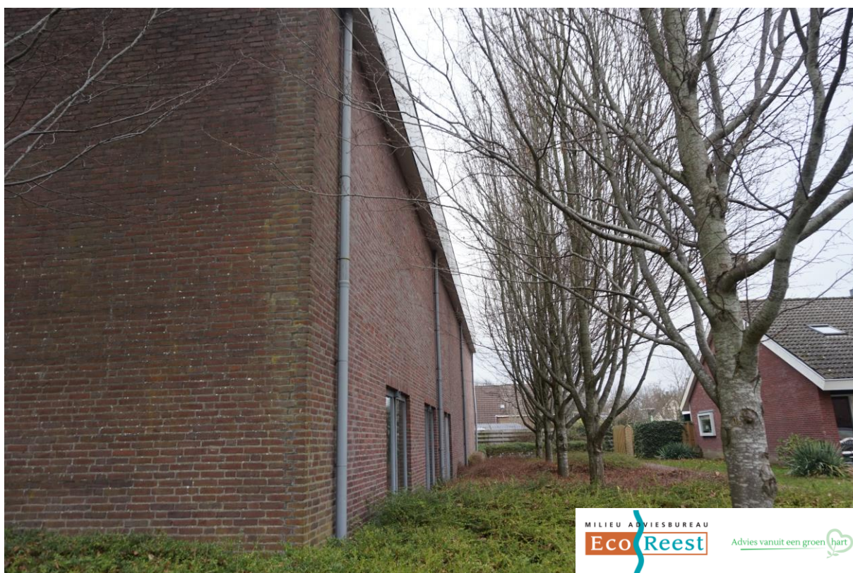
Figuur 2.5. Zuidoostzijde van de onderzoekslocatie.
