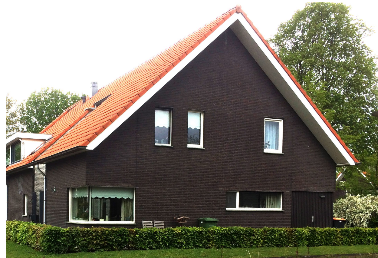
bestaande alzijdige blokjes met zwarte onderbouw, witte accenten en rode pannen
