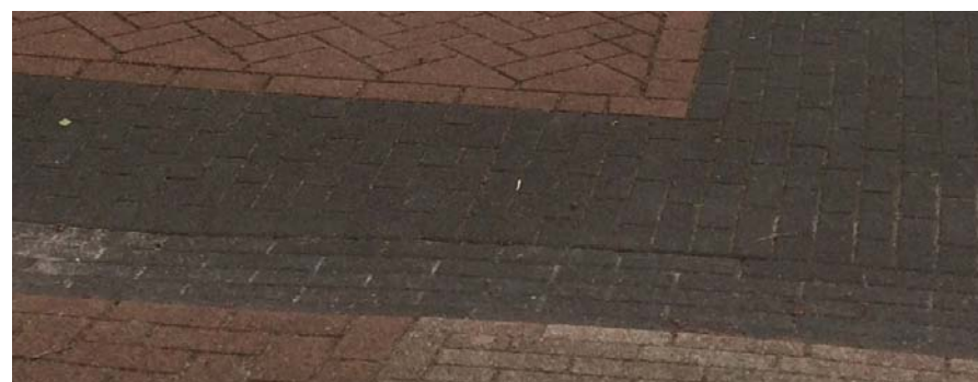
hergebruik zwarte betonklinkers van de parkeerplaats
