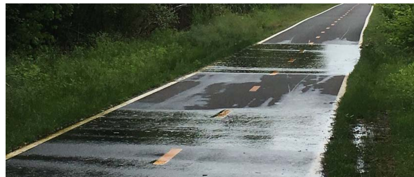
Door een kleine verlaging in het voetpad vloeit het water zichtbaar over het voetpad naar de wadi
