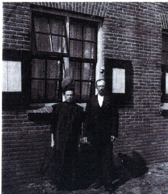
Izaak Hoogeveen en Aaltje Faken waren de eerste bewoners van één van de dubbele arbeiderswoningen aan de Van Helomaweg, gebouwd in 1920.
