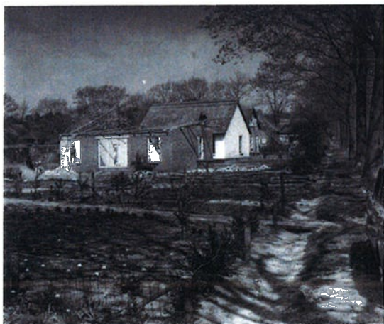
De 'bungalows' zijn niet levensbestendig en reeds in 1971 worden de eersten alweer afgebroken aan de Veldweg. Hier de afbraak aan de Kamperweg
