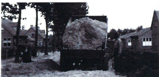
Als alle woningen in de Linthorst Homanstraat zijn bewoond, wordt de bestrating aangelegd in 1948.
