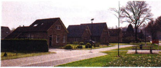
De karakteristiek gevelrij uit 1947 van de woningen aan de Klinke wordt doorbroken door een nieuwe woning. Ook Darpers gaan met hun tijd mee. Zorg is besteed aan de vormgeving, gevelindeling en materiaalkeuze.
