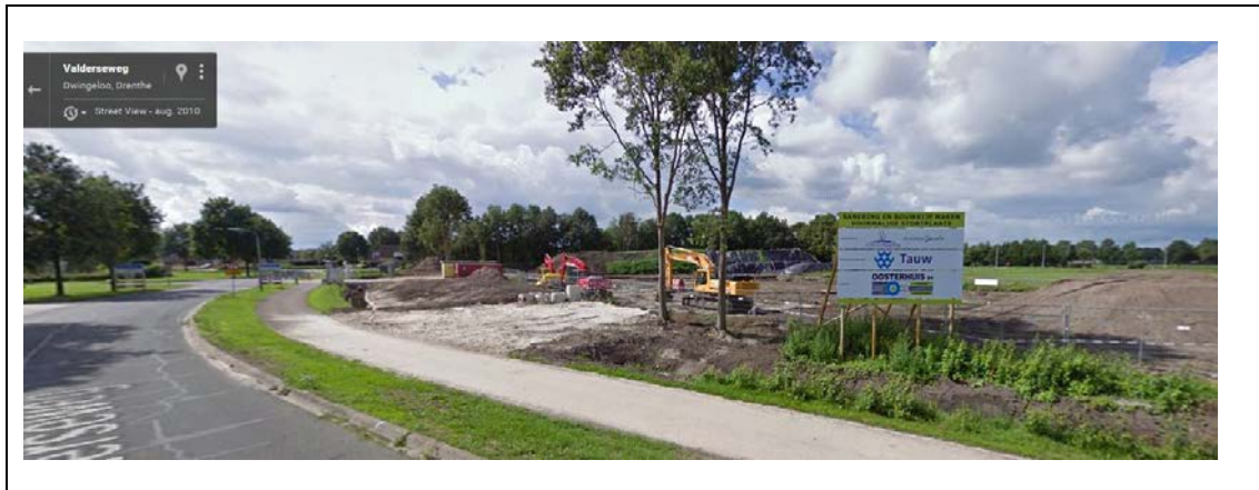
Figuur 2.3: ontgravingswerkzaamheden bodemsanering augustus 2010 (bron: Google)
