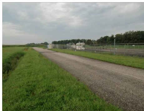
Fig. 2.13: De aansluiting op de boorlocatie Nijensleek.
