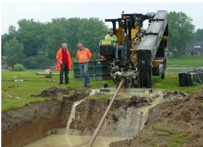
Figuur 3 Booropstelling ten behoeve van een gestuurde boring/persing
