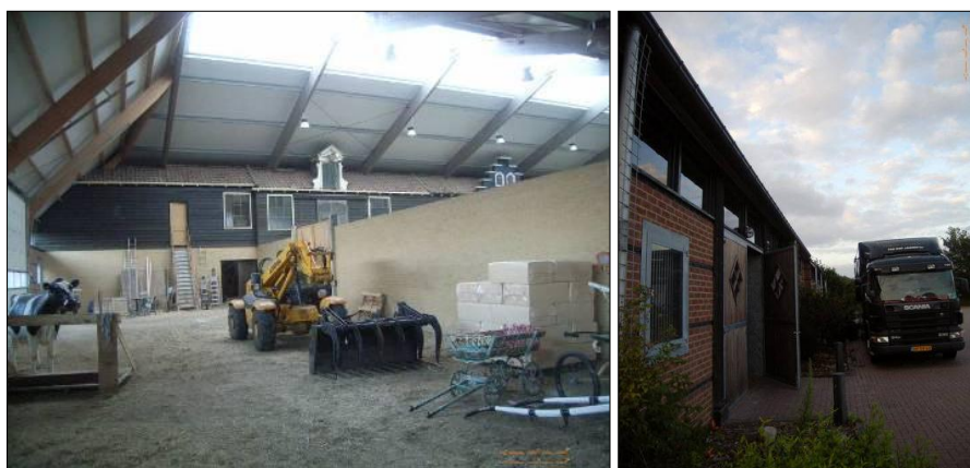
Zuidzijde rijhal binnen en buiten
