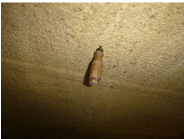
Inspectie plafondbeplating schuur 8
