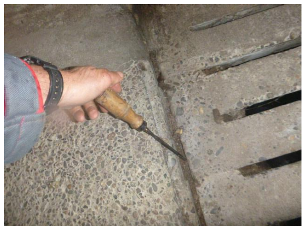
Inspectie mestkelder schuur 8
