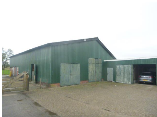
Buitenzijde schuur 6 en schuur 7
