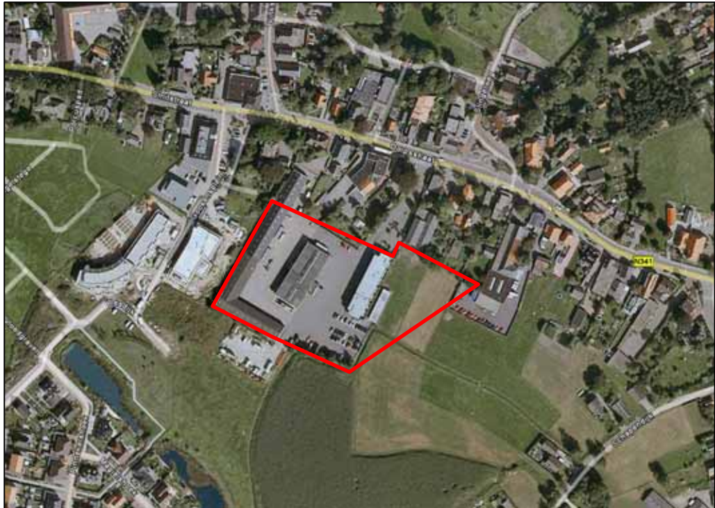
Bestaande situatie noordelijk deel plangebied
