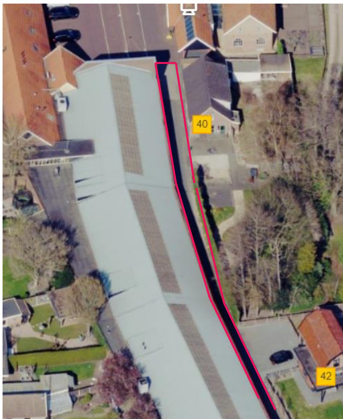
Figuur 2 doorgang tussen opstallen
