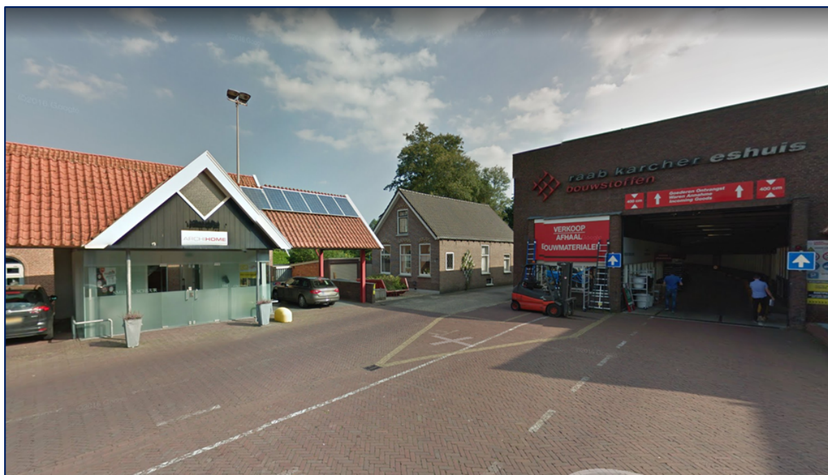
Figuur 2.1: huidige situatie Oosteinde 40 Vriezenveen (bron: Google streetview).
