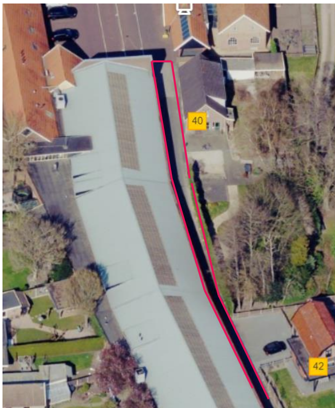
Figuur 2 doorgang tussen opstallen
