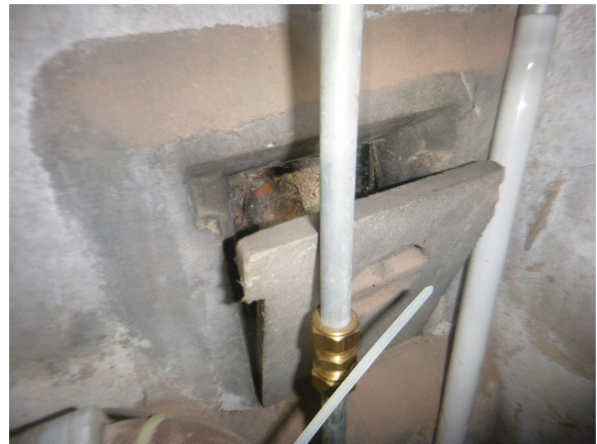
Inspectie schoorsteenkanaal via luik
