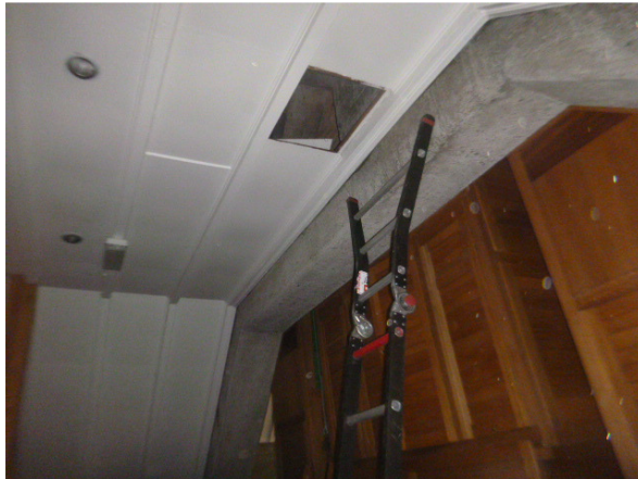
Inspectie boven plafond
