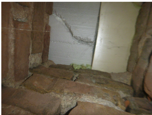
Inspectie schoorsteenkanaal via luik
