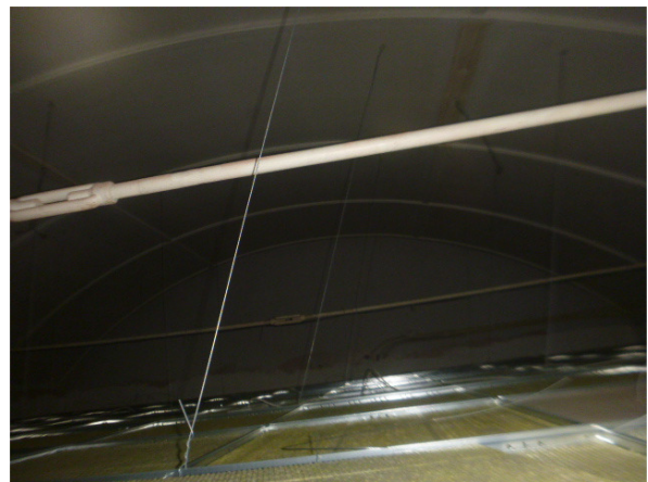
Inspectie boven systeemplafond
