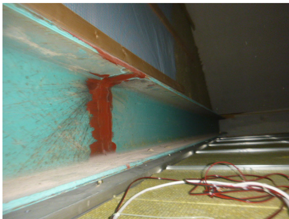
Inspectie boven systeemplafond
