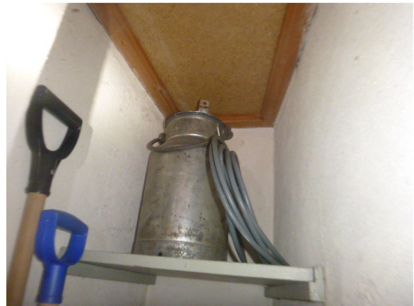
Inspectie plafond in kast
