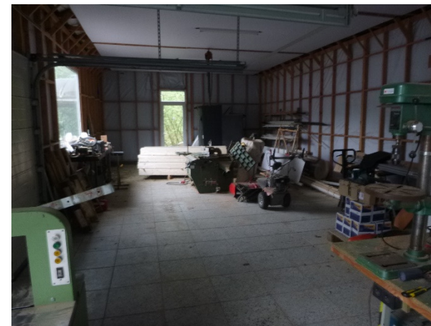
Te slopen schuur
