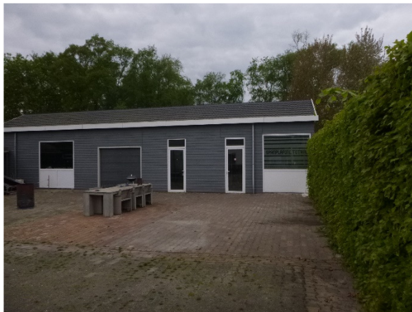
Te slopen schuur
