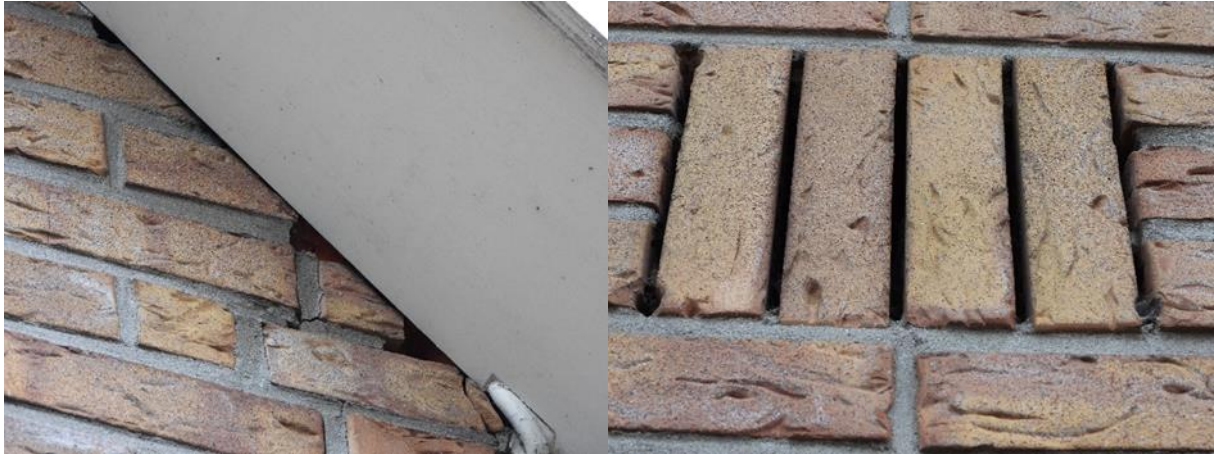
Foto links; vleermuizen kunnen een verblijfplaats bezetten achter de kieren tussen de buitengevels en de betimmering van het dakoverstek. Foto rechts; vleermuizen kunnen de spouwmuur bereiken via ventilatieopeningen en daar een verblijfplaats in bezetten.
