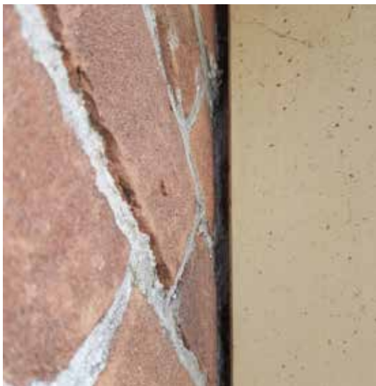
Ruimte van minder dan 1cm op de aansluiting van de windveer op de buitenmuur.
