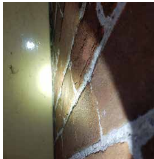
Ruimte van minder dan 1cm op de aansluiting van de windveer op de buitenmuur.
