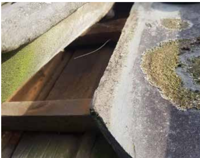
Inspectie van het pannendak.
