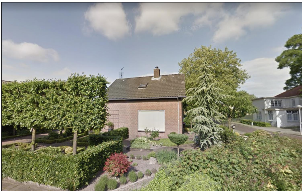
Afbeelding 2.4 Straatbeeld bestaande woning Begherstraat 1 (Bron: Google Streetview)
