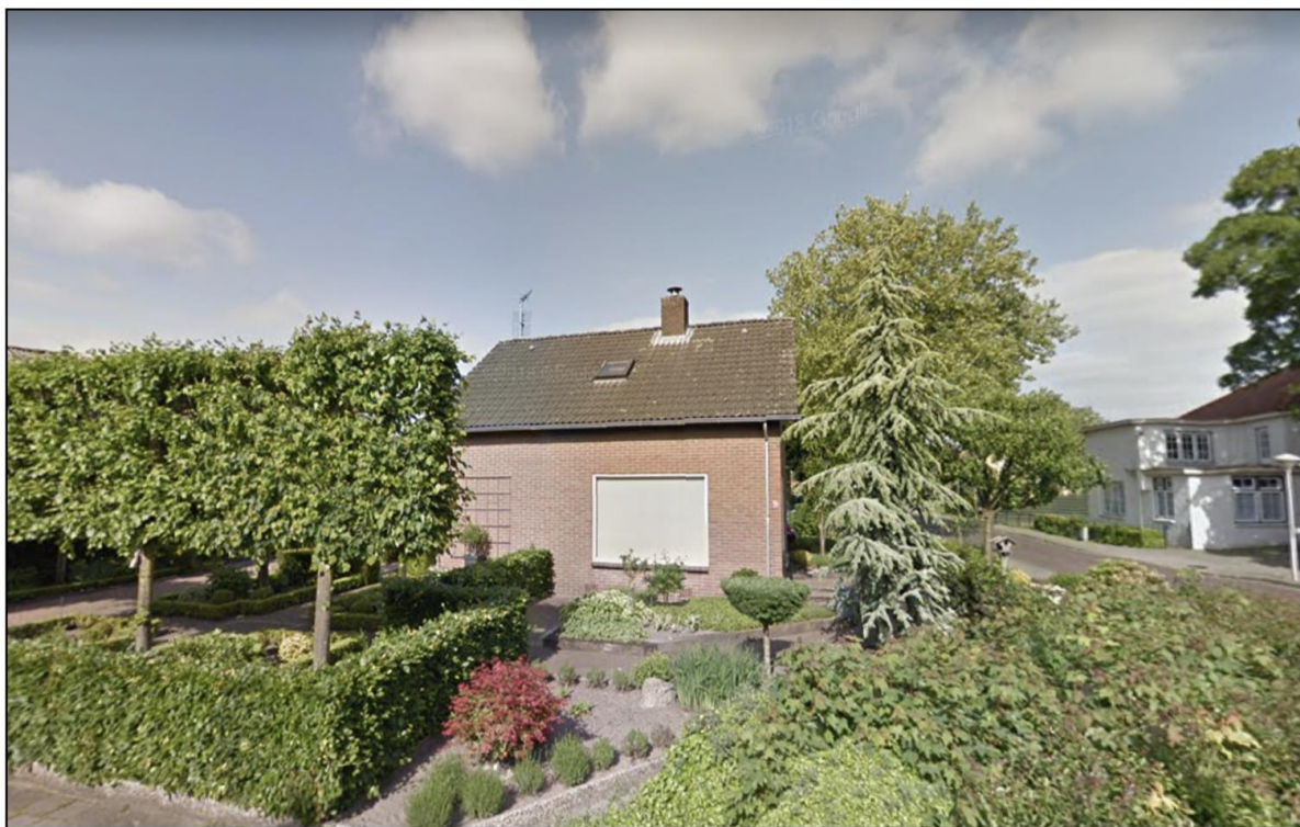
Afbeelding 2.4 Straatbeeld bestaande woning Begherstraat 1 (Bron: Google Streetview)
