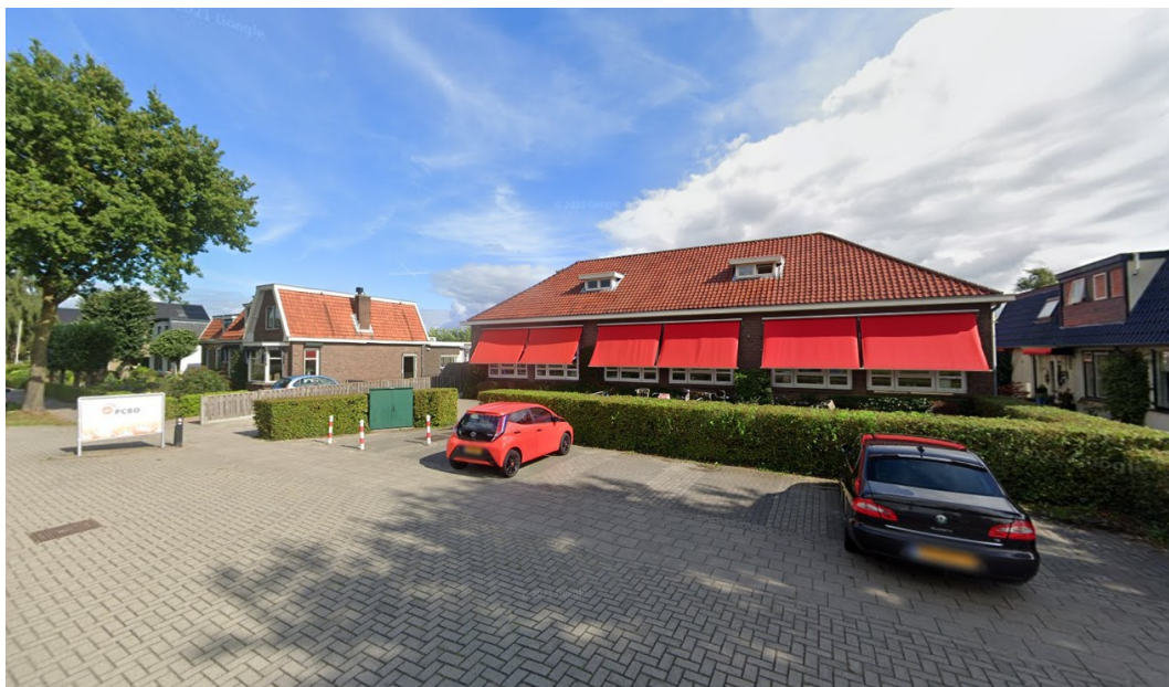
Figuur 10: De gebouwen in het plangebied gezien vanaf de Oranjestraat ('Google Maps', Street View, september 2021).
