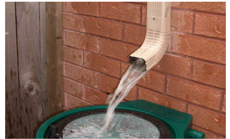
Koppel regenwater af op eigen terrein
