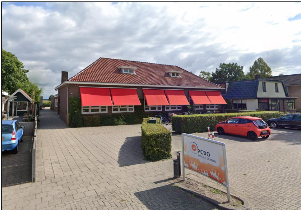
Huidige situatie van de Oranjeschool (bron: Google streetview).
