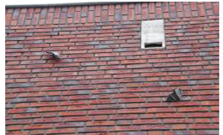
Ingemetselde nestgelegenheden voor vleermuizen
