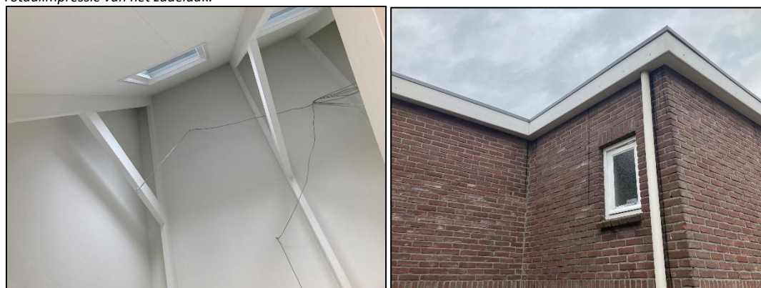
Figuur 2.7 (links): Impressie van het binnenaanzicht van het zadeldak, gelet op de bedekking, kan er vanuit gegaan worden dat er een vorm van isolatie aangebracht is; Figuur 2.8 (rechts): Impressie van gevel en de daklijst van het achterste gedeelte van het pand.
