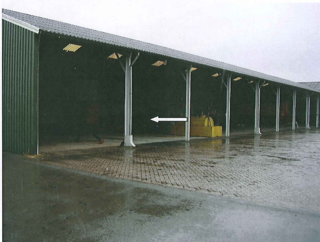
Wagenberging met opslag oliën in vloeistofdichte bak en vloer
