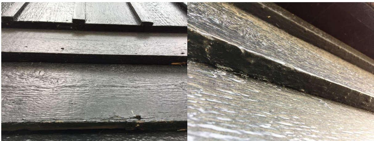
De planken sluiten strak op elkaar aan.
