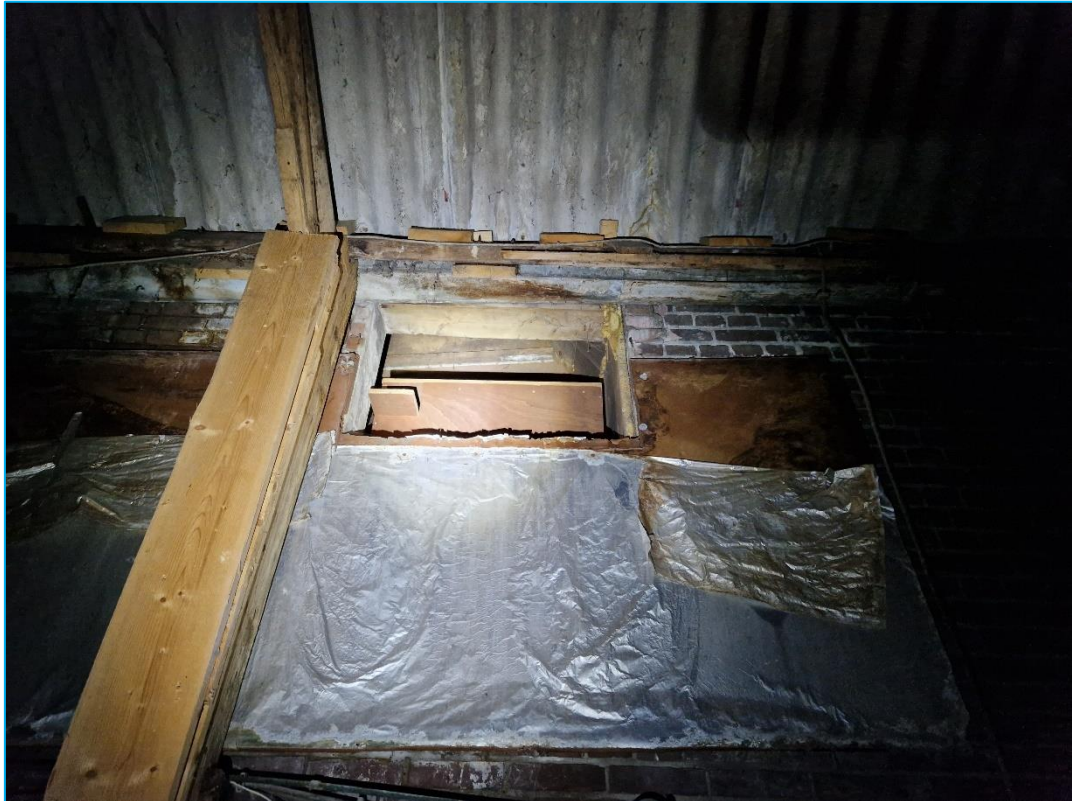
Foto: Kerkuilenkast in gevel bij de te behouden woning.
