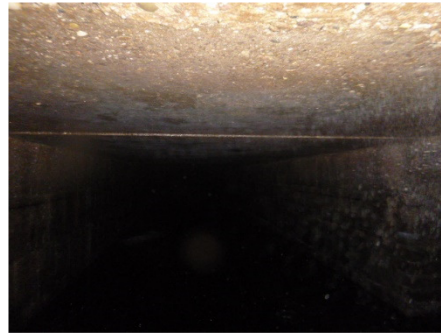
Inspectie mestkelder via pompgat
