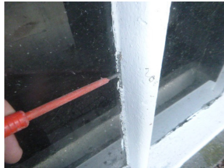
Inspectie betonraam
