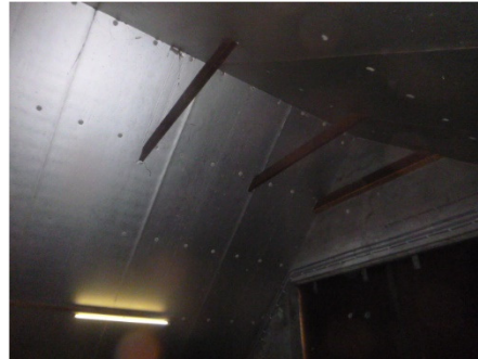
Isolatie binnenzijde dak garage
