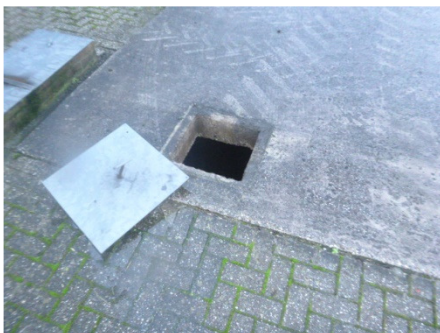
Inspectie mestkelder via pompgat
