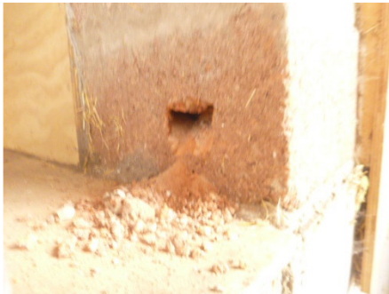
Inspectie schoorsteen (destructief)
