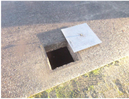
Inspectie mestkelder via pompgat
