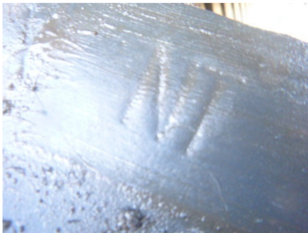
NT-golfplaten op dak
