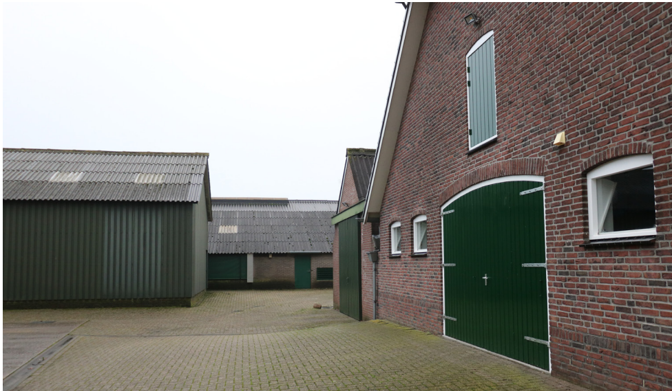
Figuur 4 Centrale erfruimte en achterzijde boerderij
