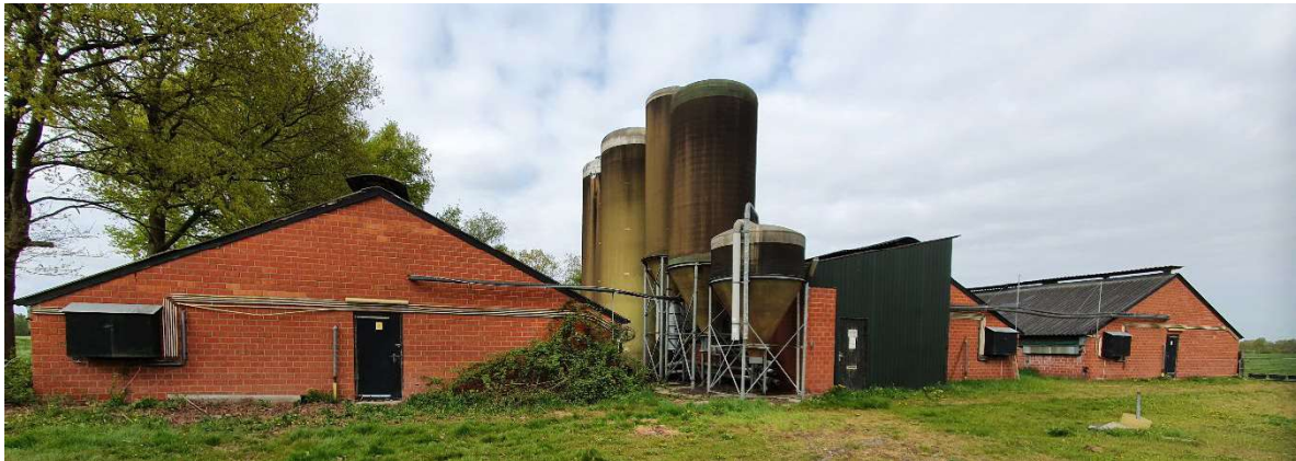
Voormalige en te verwijderen stallen achterop het erf – Lindrot 6A.
