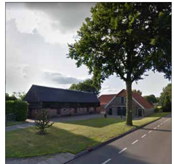
het achtererf met de te slopen opstallen
