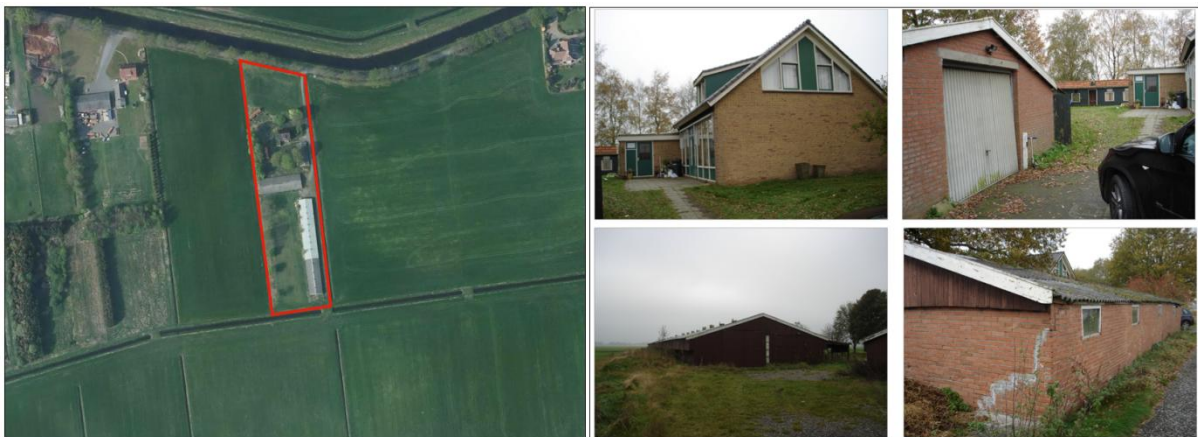
Figuur 2.3: Huidige situatie Grintweg 14 (Bron: provincie Overijssel & Eelerwoude)
