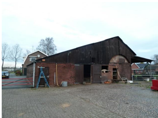
Afbeelding 5 overzicht erf met de te slopen stal en op de achtergrond de te behouden woning (Wierdenseweg 33)
