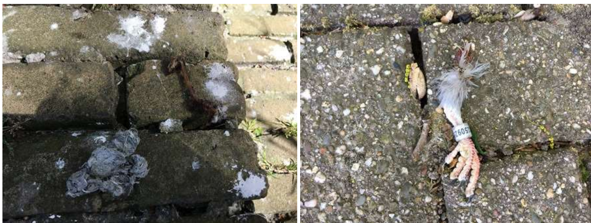
Schijt en prooiresten aan de voet van de watertoren; sporen die op de aanwezigheid van een slechtvalk duiden.
