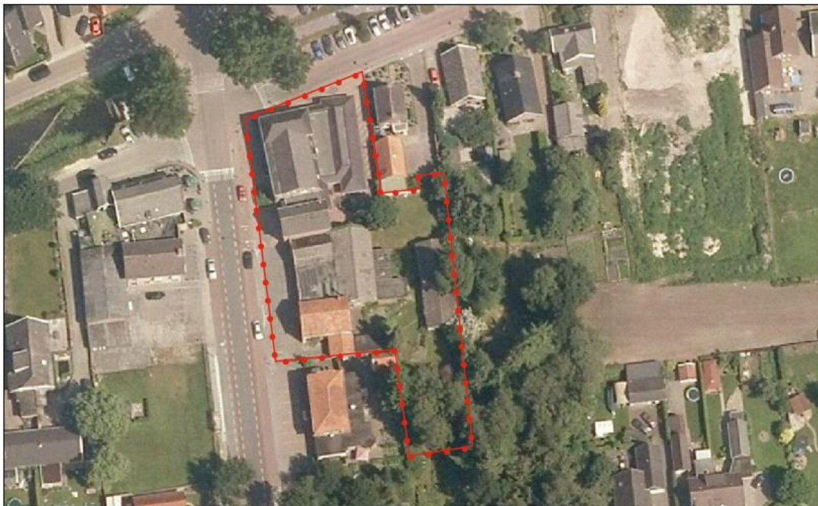
Afbeelding 2.1: Luchtfoto van het projectgebied (Bron: Provincie Overijssel)
