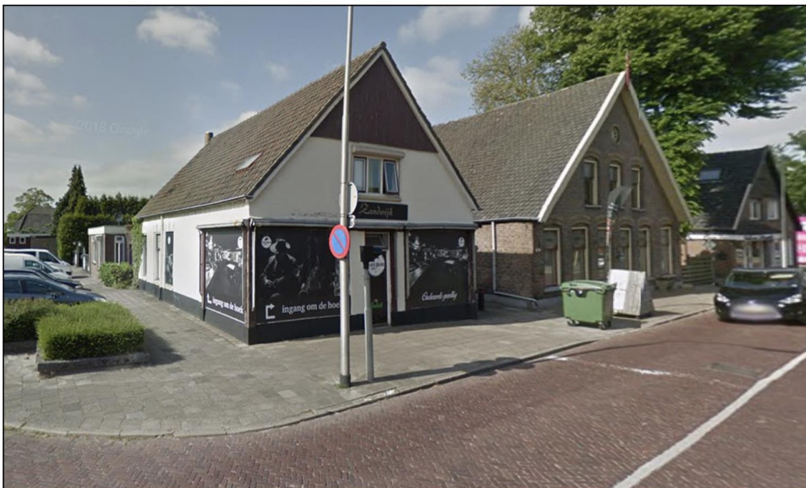
Afbeelding 2.3 Straatbeelden Westeinde 676 (links) en Westeinde 674 (rechts) (Bron: Google Streetview)
