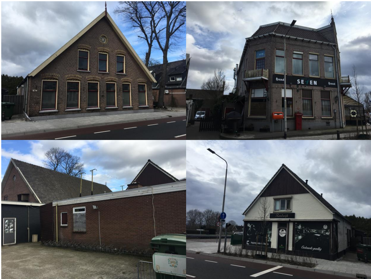
Impressie van de te slopen bebouwing
