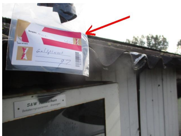
Bron 1B AC golfplaten dak.
