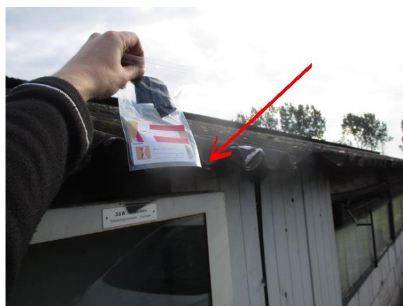
Bron 1B AC golfplaten dak.
