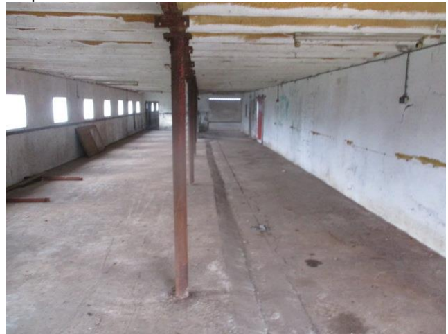
Binnenzijde van de stallen zijn geen asbestverdachte materialen aangetroffen.
