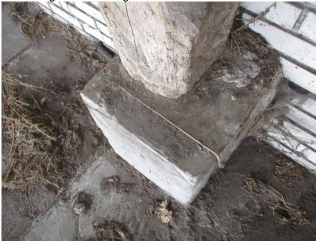
Geen asbestverdacht stelmateriaal verwerkt in constructie.
