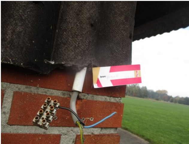
Bitumen gevelbekleding niet asbesthoudend.
