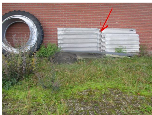
2B losliggende golfplaten 1 stapel
