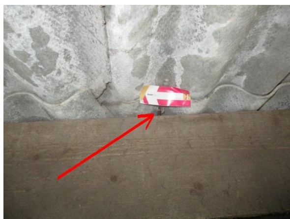
Bron 1B golfplaten dak.
