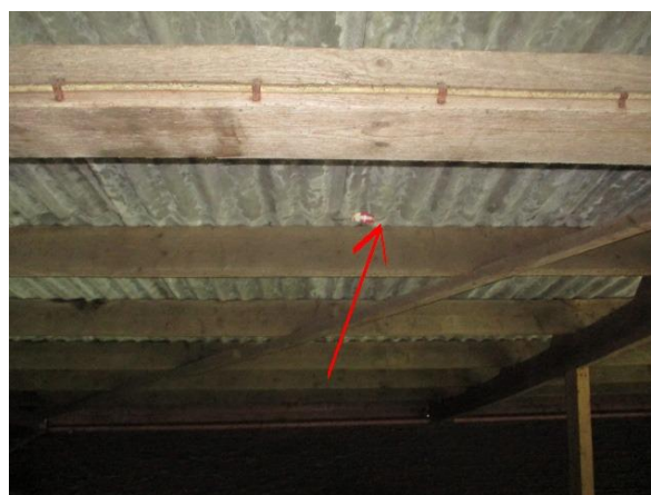
Bron 1B golfplaten dak
