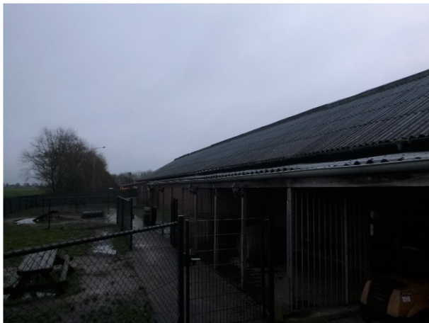
Westzijde voormalige stierenstal
