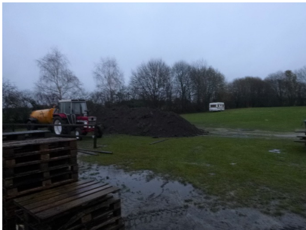
Depot vrijgekomen grond bij aanleg pad
