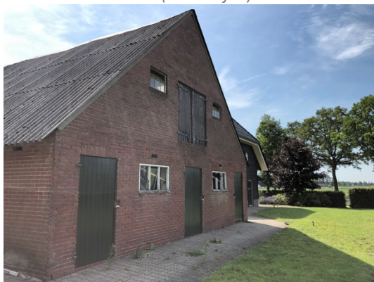
Achterzijde te renoveren schuur (noordzijde)
