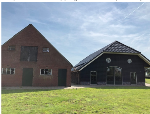
Achterzijde te renoveren schuren
