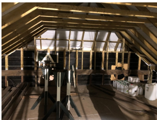
Binnenzijde te renoveren schuur (zuidzijde)
