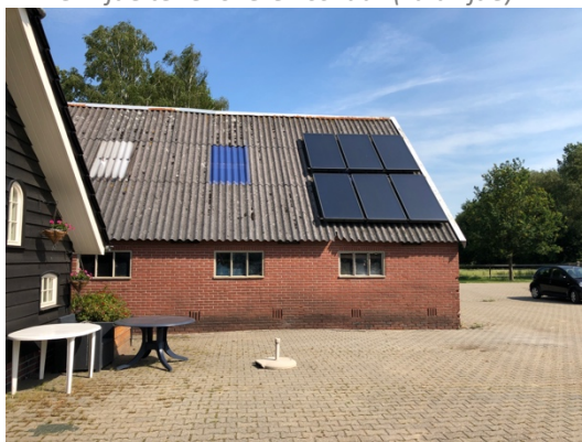
Zijkant te renoveren schuur (noordzijde)
