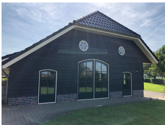
Te renoveren schuur (zuidzijde)
