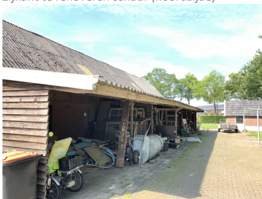
Aanpalende overkapping aan schuur (noordzijde)
