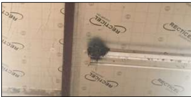
Boerenzwaluwnest in één van de te slopen stallen.
