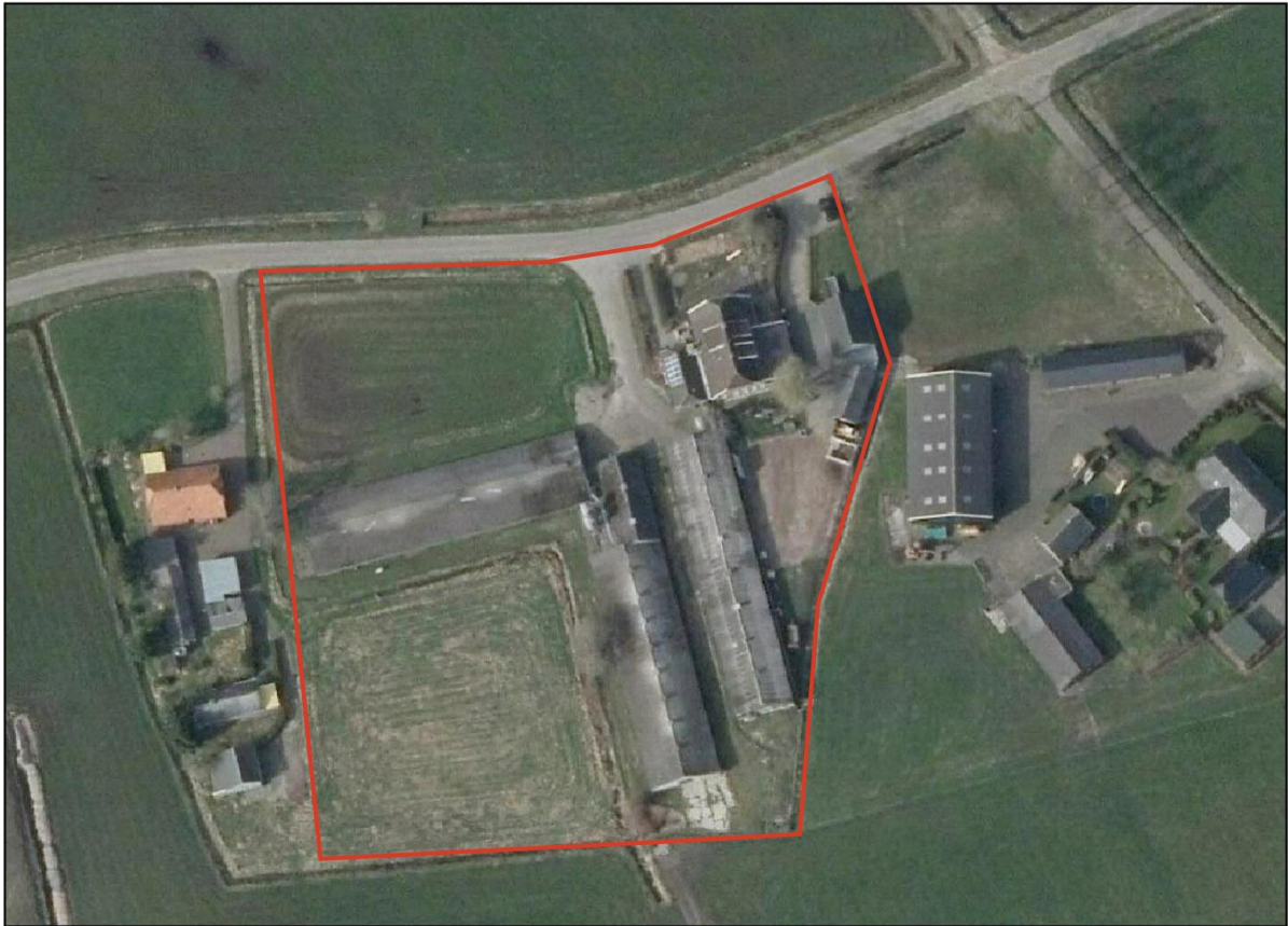
Afbeelding 2.2 Huidige situatie slooplocatie (Bron: Provincie Overijssel)
