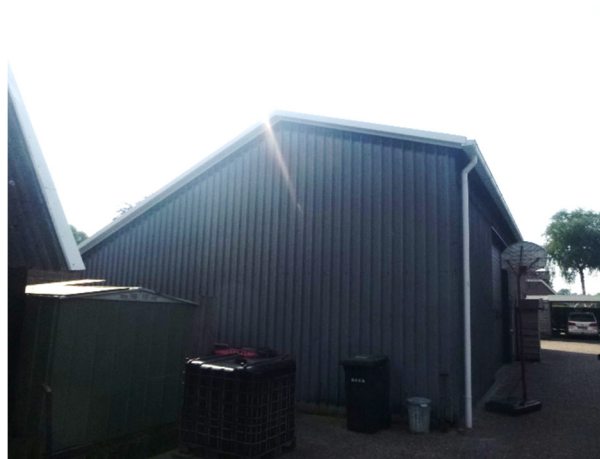
Schuur ten oosten van de woning
