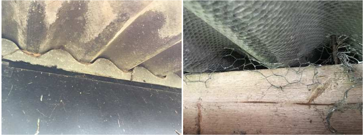
Afdichting van de openingen onder de golfplaten. Hierdoor kunnen soorten als bruine rat en steenmarten geen verblijfplaats bezetten onder de golfplaten.
