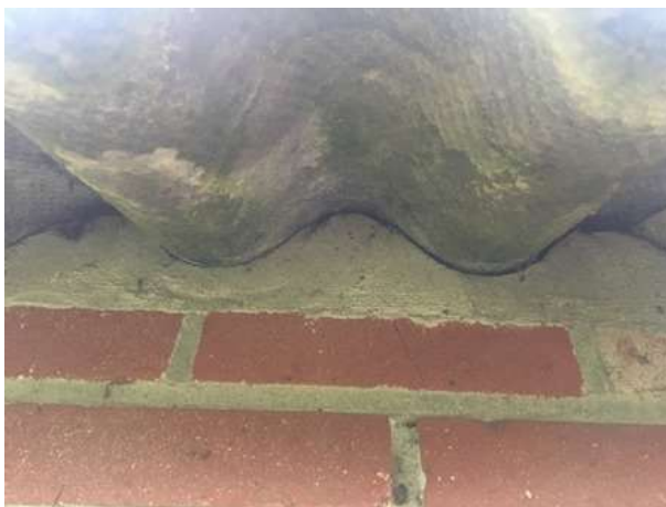
Afgedichte openingen onder de golfplaten; hierdoor kunnen soorten als bruine rat en steenmarter niet onder de golfplaten komen.
