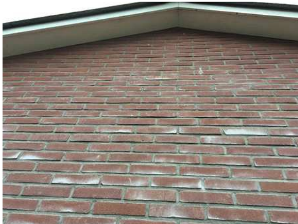
Zijgevel van de stenen stal; geen open stootvoegen en geen kieren tussen de overstek en de muur. Hierdoor is de spouw niet bereikbaar voor vleermuizen.
